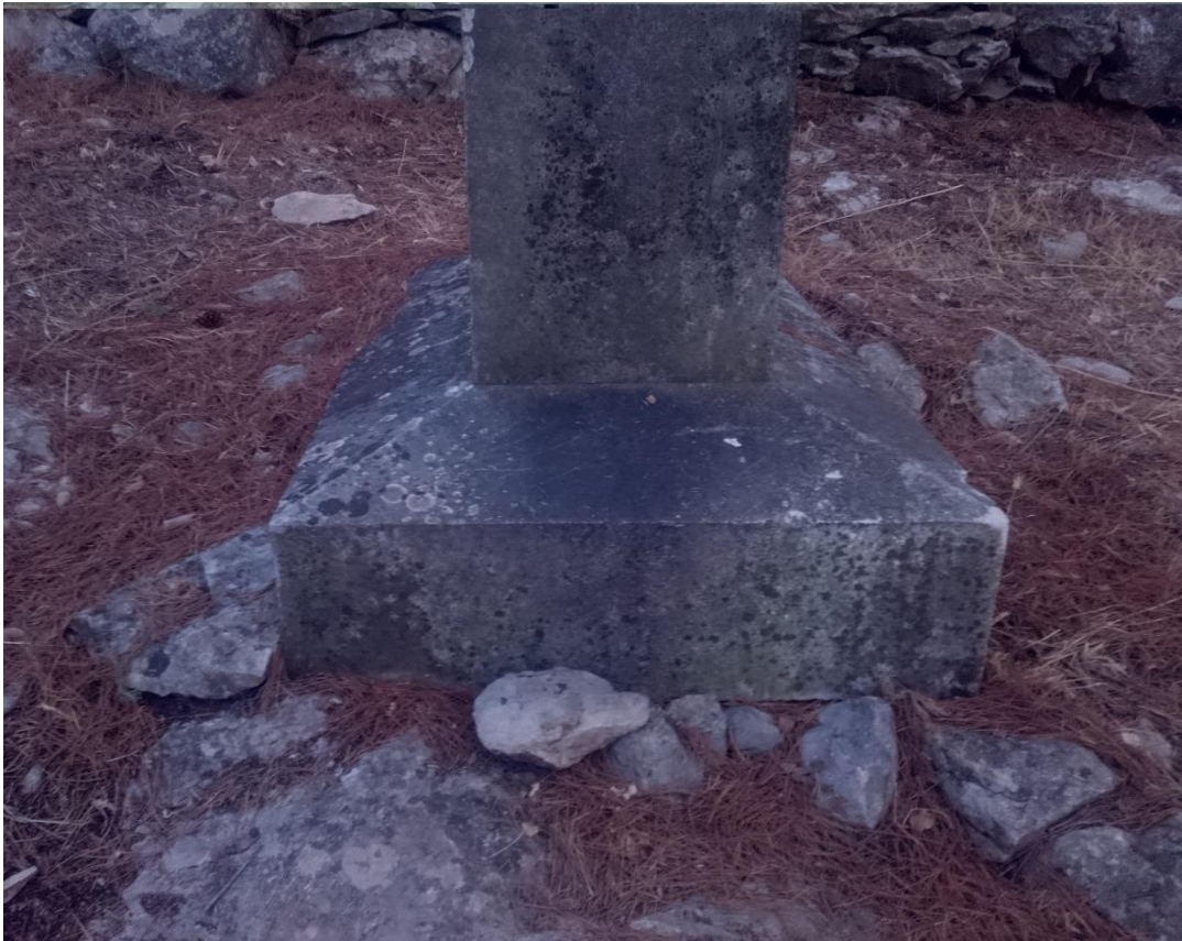
Slika 2. Kameni podij i dio tijela spomenika s vidljivim biološkim obraštajem
